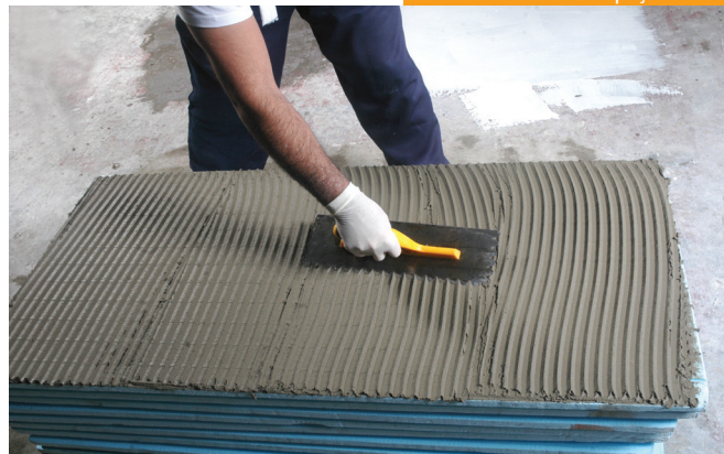
Düzdün yüzeylere uygulama yapılacağı zaman levhanın arkasına sürülen harç tarak ile eşit bir şekilde yayılır. Taraklama yapıldıktan sonra kenarlara harç taşmamasına özen gösterilir.
